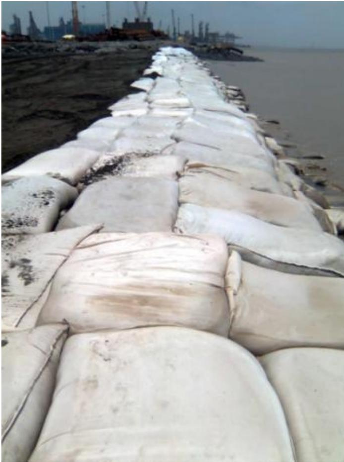
Questa tipologia di barriere è spesso impiegata come rivestimento di pendii verso il mare o come strutture sotto costa. Tuttavia, rispetto ad altre strutture, i costi di realizzazione sono piuttosto variabili a causa della difficoltà di posizionamento.
